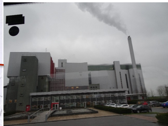
7.廃棄物CHP(60MW) DHの約25%を供給
